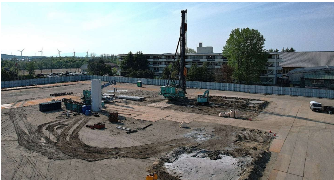
2025.5.16 ドローン撮影写真
